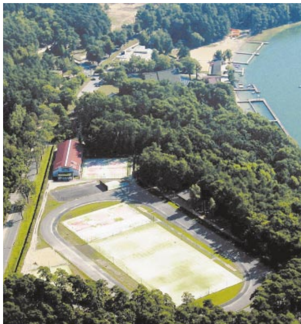
Widok z góry: ośrodek w trakcie przebudowy
